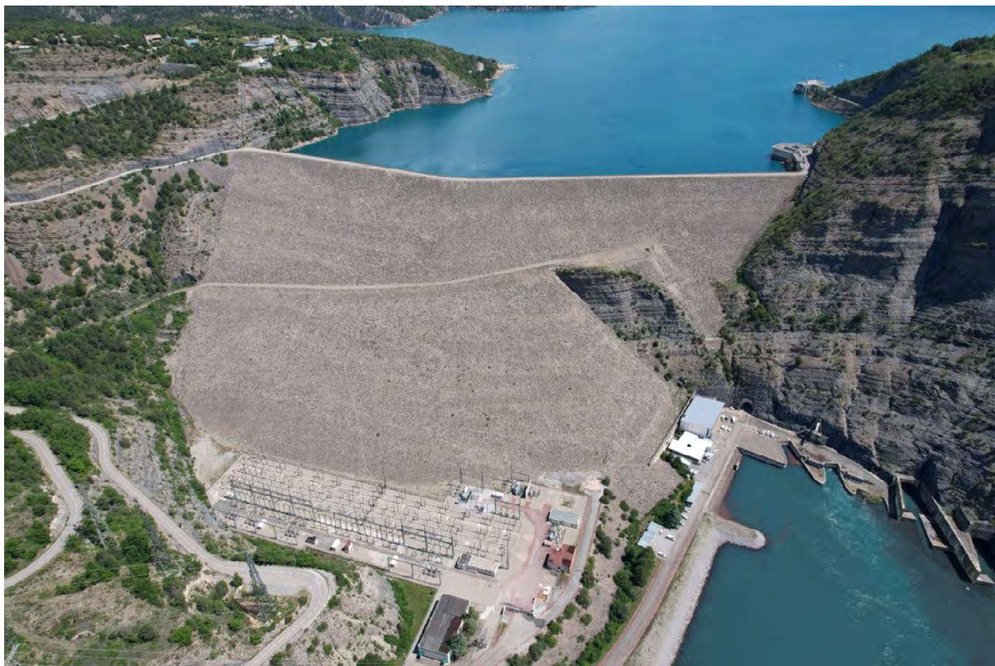
Vue aérienne du barrage EDF du lac de Serre-Ponçon © EDF
